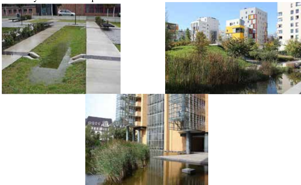
Рис. 2 Площадь с нишами-накопителями, комплекс «Даймлер-Крайслер». Берлин, Германия
