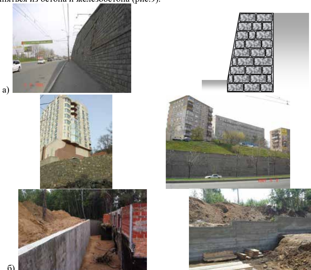
Рис. 9. Массивные подпорные стенки: а – каменные; б - бетонные
