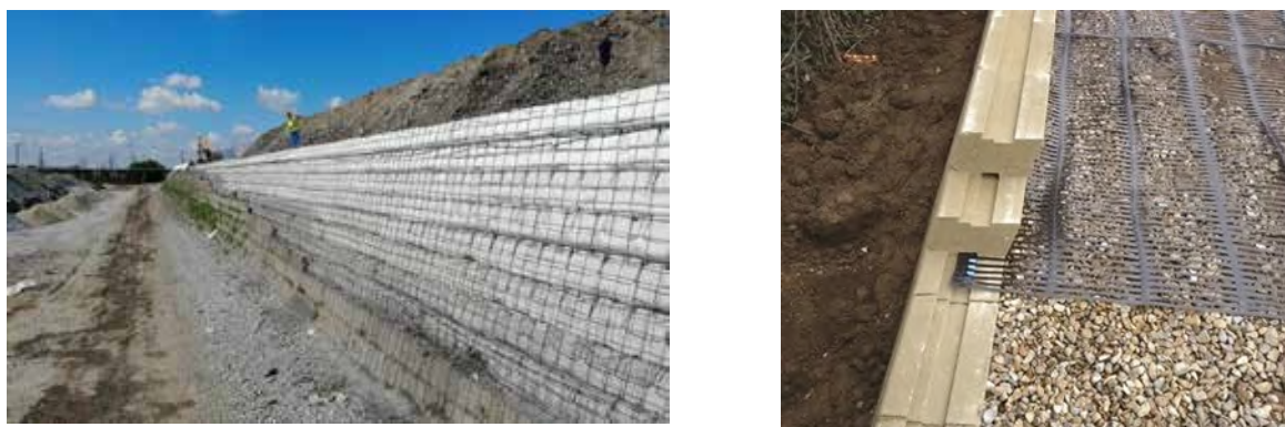
Рис.13. Подпорная стена из армированного грунта
