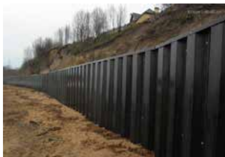
Рис.12. Тонкие шпунтовые подпорные стены
