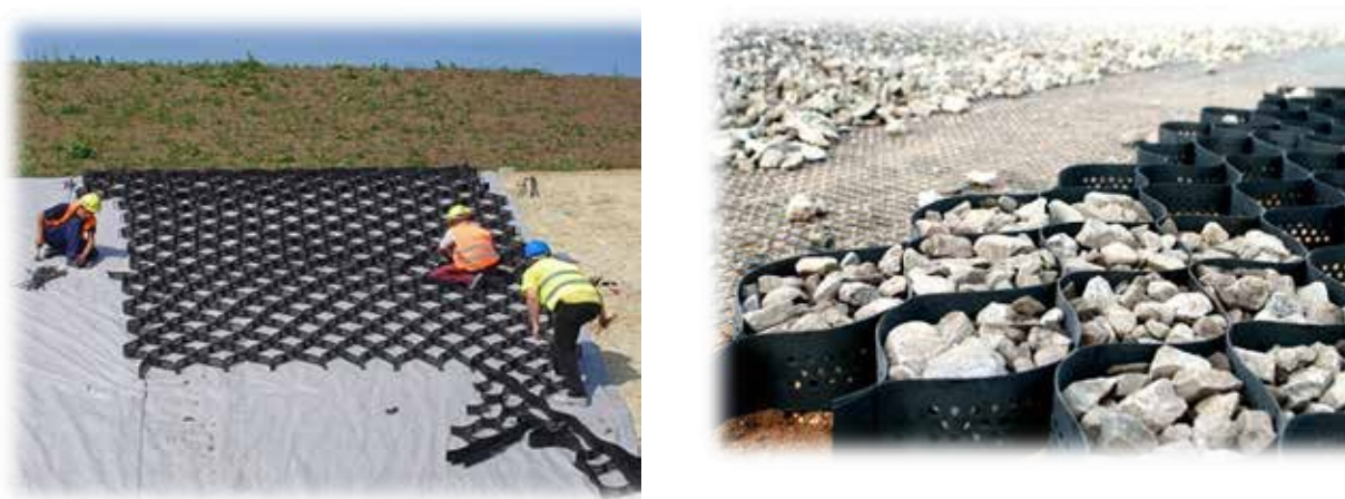
Рис.15. Подпорная стена армированная георешеткой
